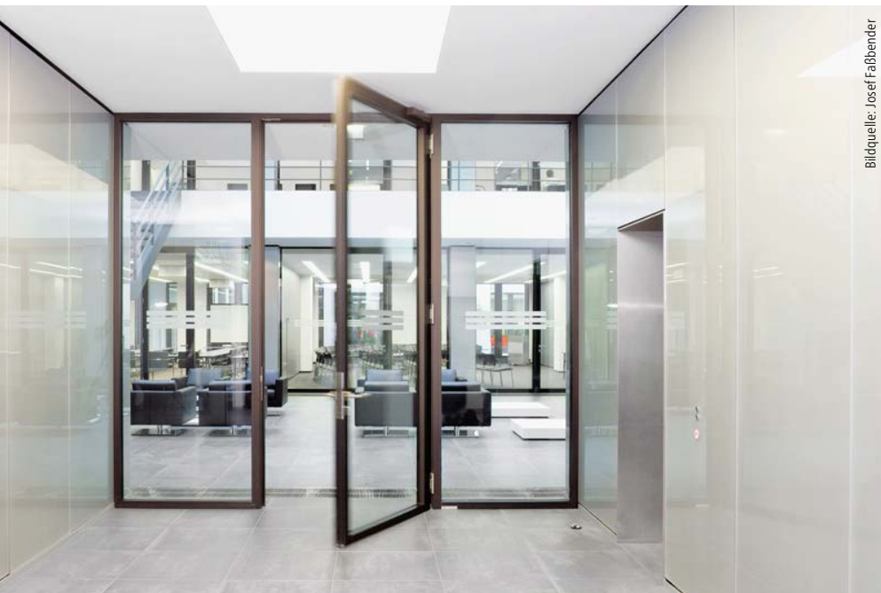
Abb. 1: Feuerschutzabschluss mit großflächiger Verglasung in einem Verwaltungsgebäude
