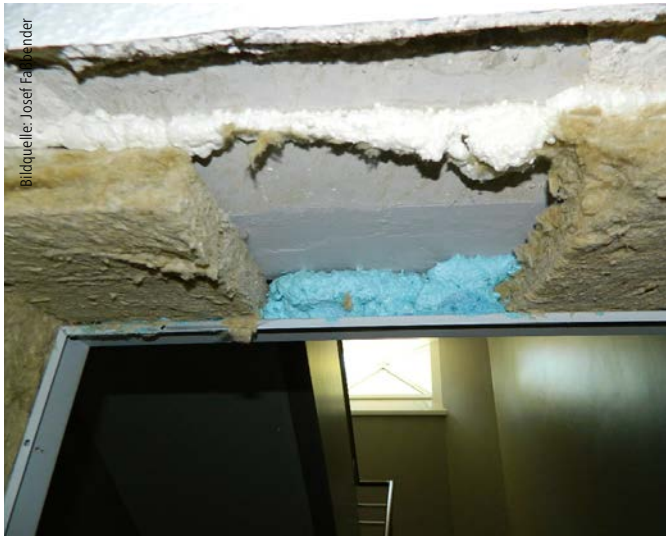
Abb. 2: Hinterfüllung der Zarge mit nicht zugelassenen und unterschiedlichen Materialien
