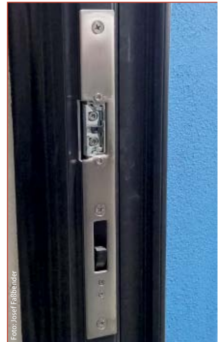
Abb. 5: Elektroöffner und Riegelschaltkontakt
